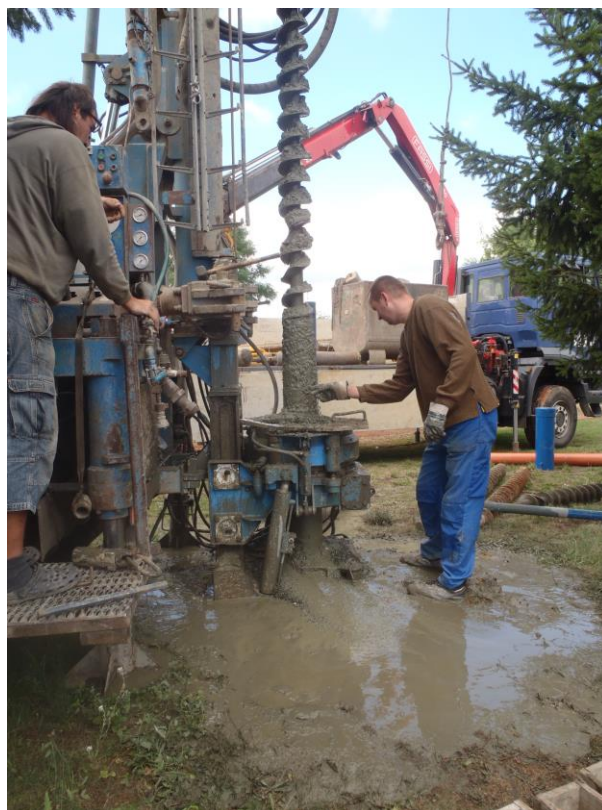
Foto 1: pohled na vrtání vstrojeného vrtu S-1
