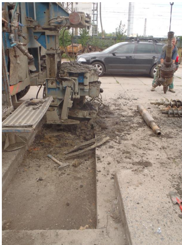
Foto 2: pohled na vrtání na zpevněných plochách (vrt S4)
